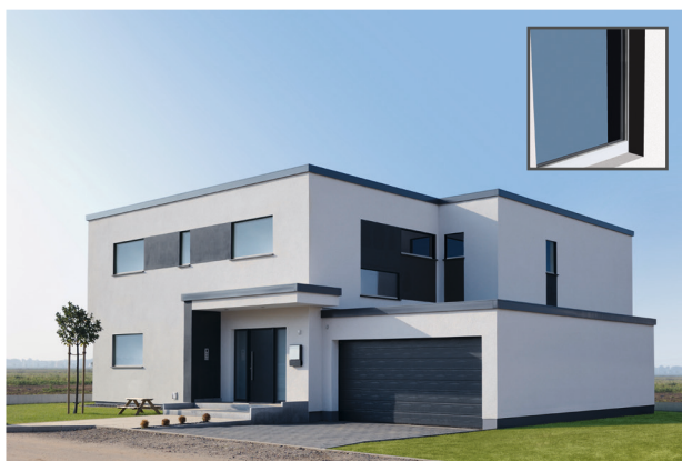
Bild 1: Wohngebäude mit Ganzglasoptik (Detail: teilweise überdämmter Rahmen)
